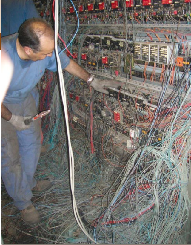
Démontage des automatismes à relais.
