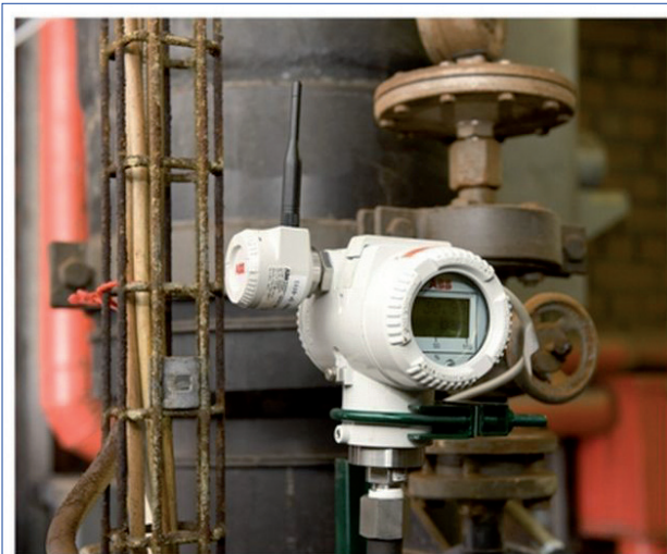
Certains appareils testés par Namur utilisaient un adaptateur pour le sans-fil (à gauche). D'autres disposaient de la technologie en interne.
