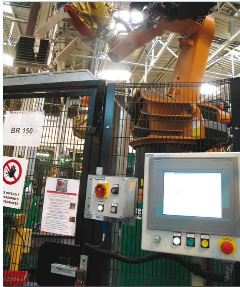
Pupitre de zone (SOP) et boîtier d'intervention (SPA) : à chaque porte, ce dernier assure la coupure générale des équipements "vus" par l'opérateur, avant qu'il ne pénètre en zone machine.
