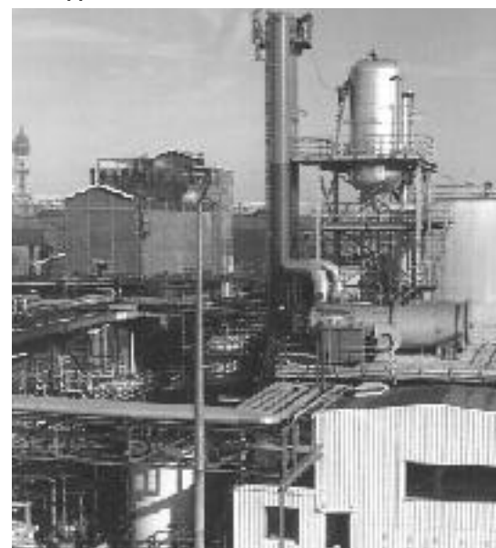
L'usine Shell de Hambourg : une application Profibus
