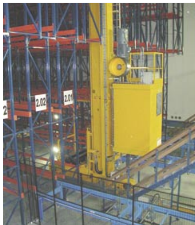
Le coeur du dispositif logistique de Charal : un magasin automatique de 8 000 emplacements.
